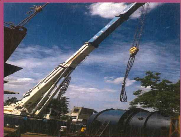
150 TON CRANE HANDLING
