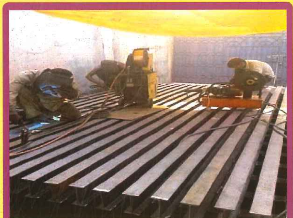
HOT PACING BED FABRICATION
